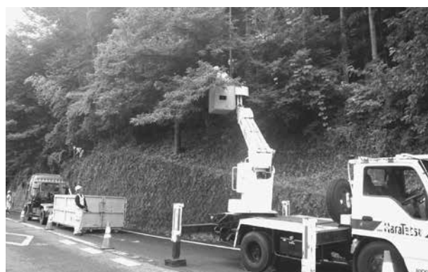
〈長野県建設業協会木曽支部ボランティア作業〉
